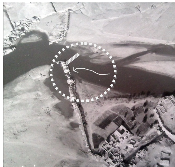
تصویر ۸. محل احتمالی سد موقت احداث شده بر پل شادروان. (مأخذ: سازمان نقشه‌برداری کشور)
